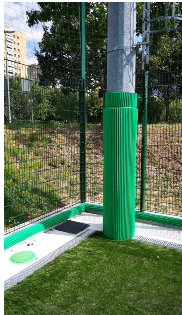
TORRE FARO E CORDOLO | ONDA 22 MM
